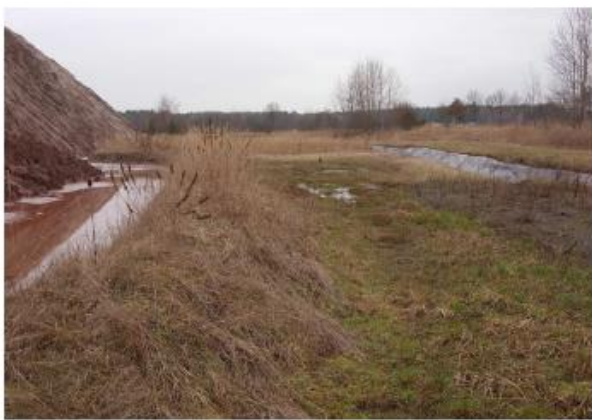
Abb. 9: Kalihalde Niedersachsen (alter und neuer Haldenrandgraben)
